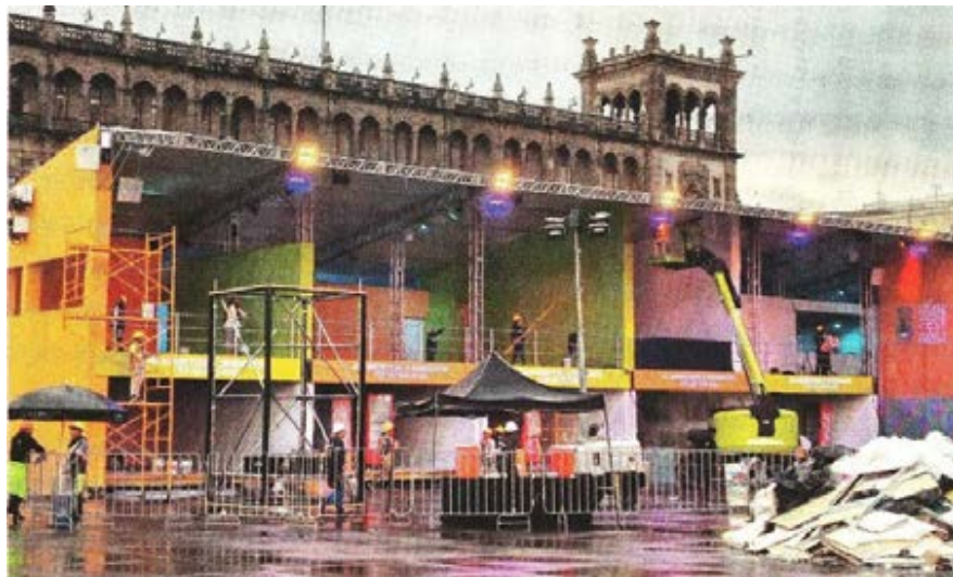
La instalación de infraestructura fue ayer interrumpida por la lluvia. Continúa en siguiente hoja
