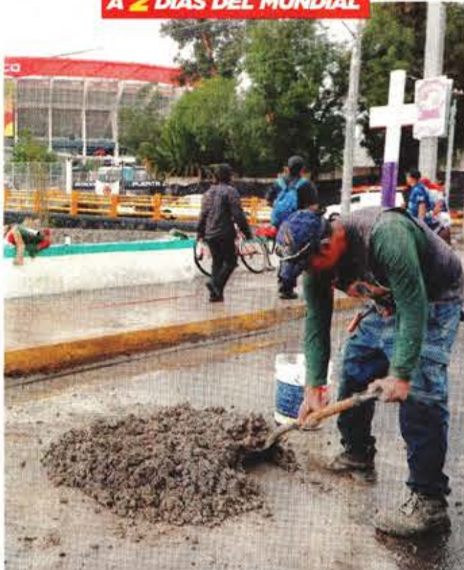
A marchas forzadas y entre la lluvia, continúan las obras afuera del Estadio mundialista en la CDMX.
